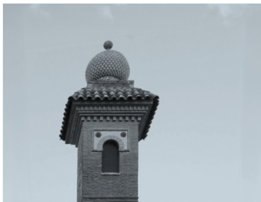
Torre d'aigua de la Clínica del Remei.
