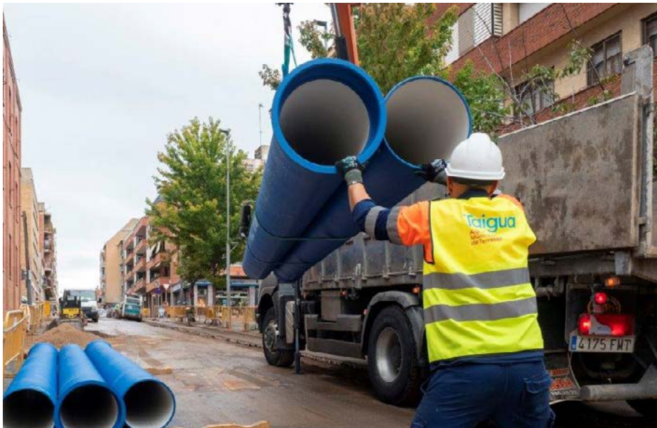
Treballadors de TAIGUA executant tasques de manteniment.
